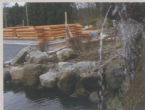
《ポプリ工房建設中です》
