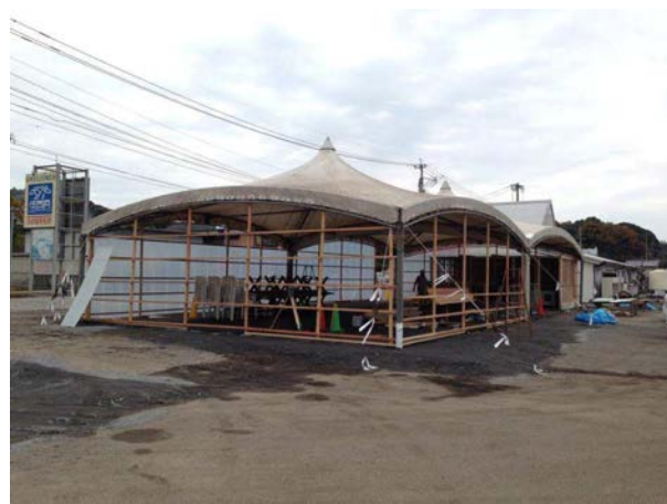
国道213号線沿いYショップ横に巨大テントが出現！
